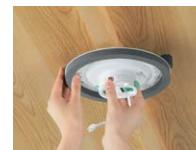
スペーサを支えながら、照明器具のアダプタを角形シーリングボディに取り付け、安定用部品を天井面にあたるまで調節します。
