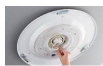
④配線器具に付属のシーリングキャップを接続し、コネクタを本体に接続します。セードを取り付けて完了です。
