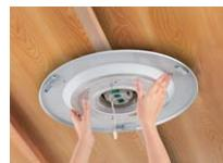
器具本体をアダプタに合わせて押し上げます。この後コネクタを接続し、セードを取り付けて完了です。
